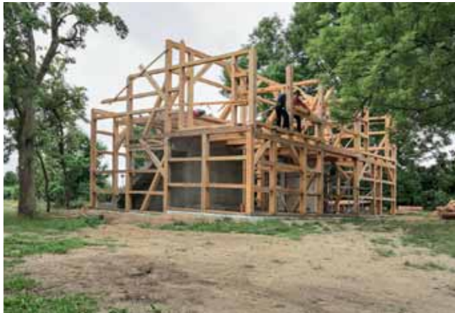
Da die rohen Hölzer nicht ganz gerade sind, wurden die Balken vor dem Aufrichten probeweise auf dem Boden zusammengesetzt und die Verstrebungen ausgelegt. Die genauen Maße wurden vom 3D-Modell auf dem Laptop abgenommen. Kleines Foto oben: Sven Fröhlich
