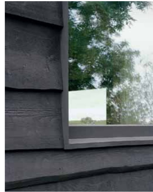
Bis in die 1980er Jahre stand auf dem Grundstück ein baufällig gewordenes Vorlaubenhaus. Das Fassadendetail ist eine Stülpschalung aus Lärche.
