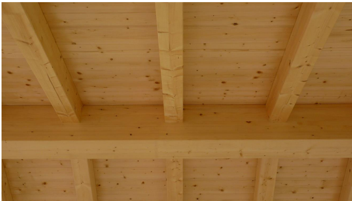
Copertura a falde vista dall'interno abitazione
